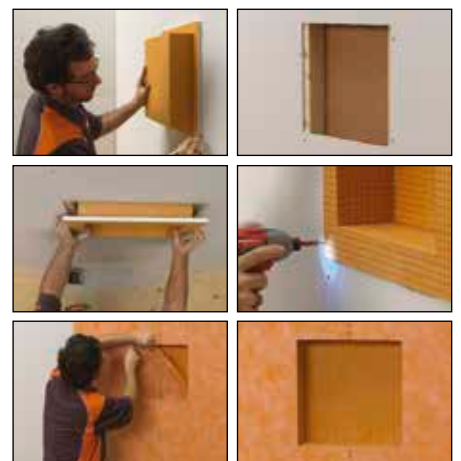
Instalação em gesso cartonado
