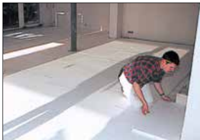
Colocação do isolamento térmico e acústico numa base com capacidade de carga suficiente e nivelada
