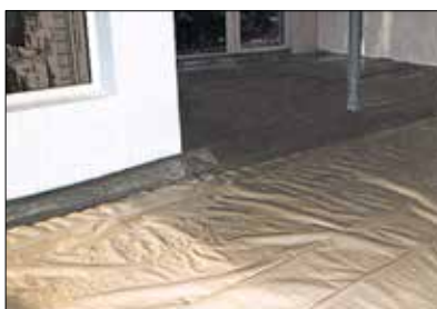
Instalação da camada de separação
