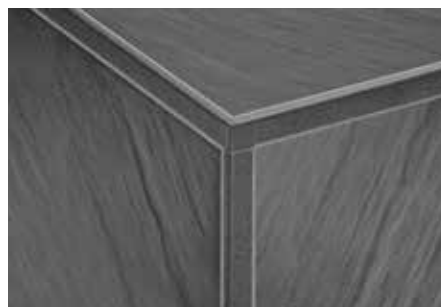
Formowanie narożnika poprzez wbudowanie kształtki narożnej
