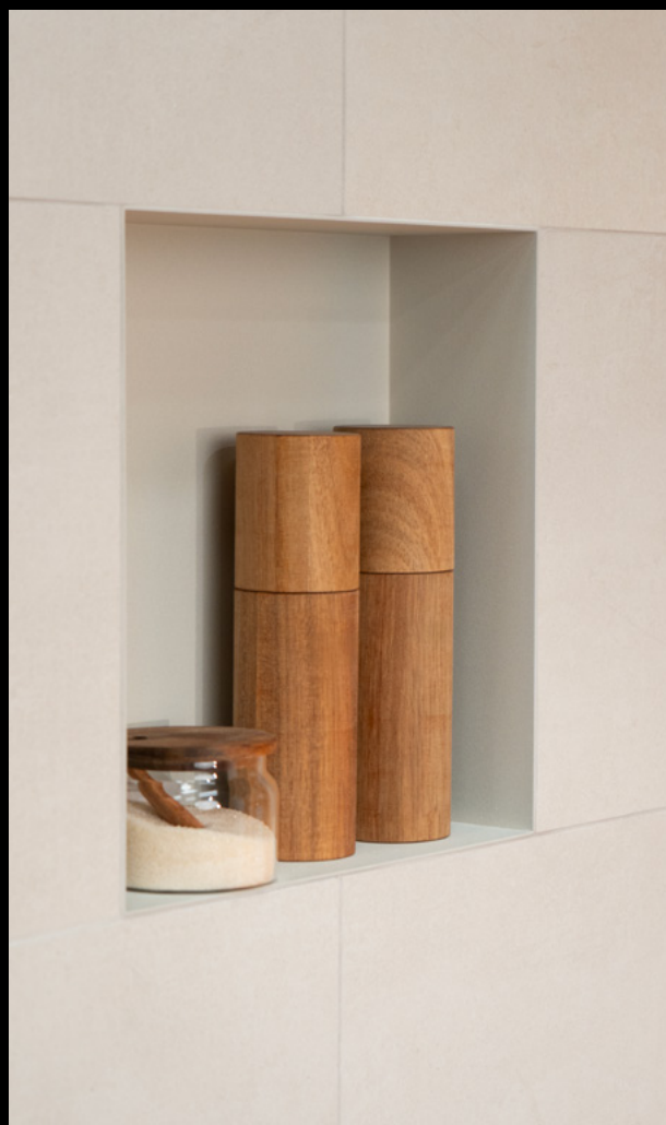
Zabudowa zlicowana z powierzchnią wyłożoną płytkami
