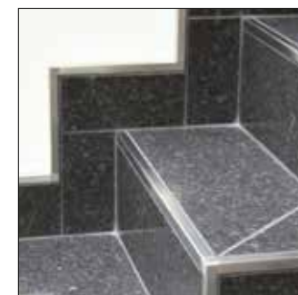
Krawędź stopni schodowych i wykończenie cokołu
