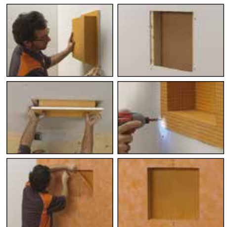
Inbouw in gipsplaat
