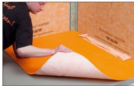
13 DITRA bzw. DITRA-HEAT aufkleben - Stöße sind mit KERDI-KEBA unter Verwendung von KERDI-COLL-L abzudichten (siehe Produktdatenblatt 6.1 bzw. 6.4).
