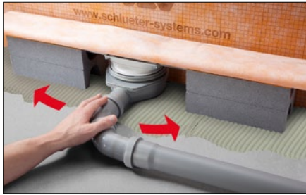
9 Ablaufrohr (bauseits) anbringen und ausrichten.
