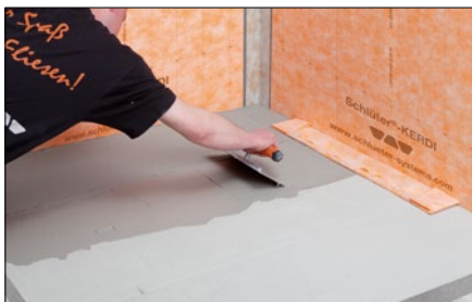
12 Die Estrichfläche mit Dünnbettmörtel versehen. Die Zahnungsempfehlung bei der Verwendung von Schlüter-DITRA ist 3 x 3 oder 4 x 4 mm. Bei der Verwendung von Schlüter-DITRA-HEAT, 6 x 6 mm.
