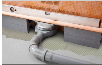
10 Rinnenkörper mit Wasserwaage ausrichten und Dichtheitsprüfung vornehmen.
