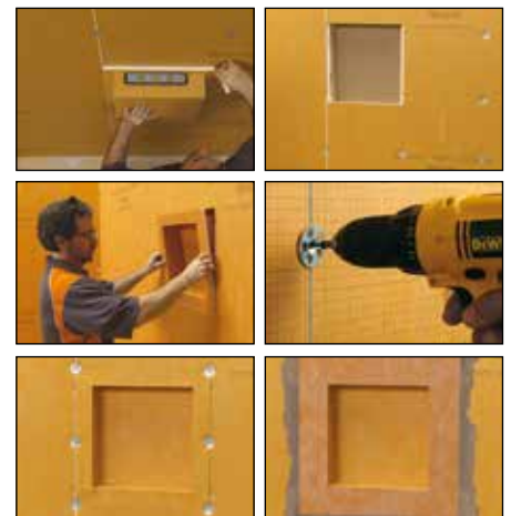
installazione in KERDI-BOARD
