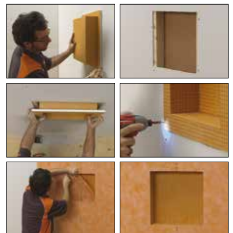
Installazione in cartongesso
