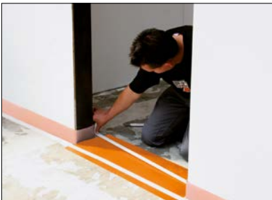
7 Türbereich – beigefügte Doppelklebebänder aufbringen.
