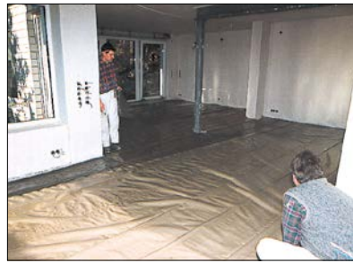
2 Einbau einer Abdecklage bei Verwendung von Fließestrichen.
