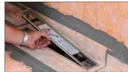
1 Konturrahmen inkl. Distanzstreifen einsetzen.
