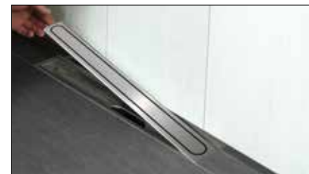
4 Nach dem Erhärten, Distanzstreifen und Höhenjustierung entfernen. Anschließend Designabdeckung einsetzen.
