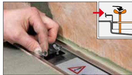
2 Konturrahmen mit Hilfe der mitgelieferten Höhenjustierung auf Belagsstärke bringen. Siehe Zeichnungsbild.
