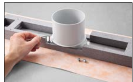
6. Zum Erreichen der minimalen Aufbauhöhe von 48 mm ist der Adapter zu kürzen. Hierzu Adapter mittels des beigelegten Imbusschlüssels vom Rinnenkörper lösen, abnehmen ...
