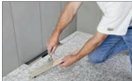
10 Belagträger mit Dünnbettmörtel versehen.
