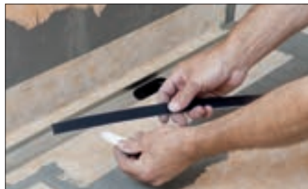
4 Beim Wandeinbau: Schutzfolie des Abdeckstreifens abziehen und ...
