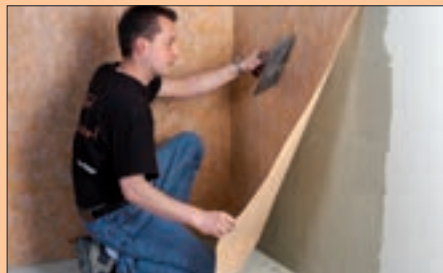
2 KERDI Bahn aufbringen und glätten.
