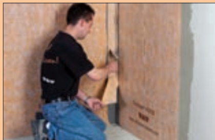
3 Im Stoßbereich mit Schlüter-KERDI-KEBA unter Verwendung von Schlüter-KERDI-COLL-L vollflächig überkleben.
