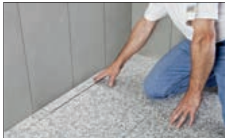
11 Belag aufkleben und ausrichten. Beim Verfugen ist der Bereich des Belagträgers auszusparen.
