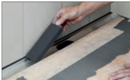
6 Distanzstücke in den Rinnenkörper einlegen und ...
