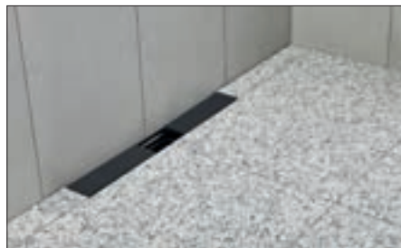
7 ... den Belag anarbeiten. Herausquellenden Dünnbettmörtel rückstandslos entfernen bzw. offene Bereiche in der Kleberschicht vollständig verschließen, siehe Hinweis.
