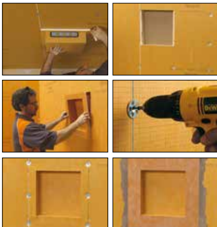
Mise en œuvre dans KERDI-BOARD
