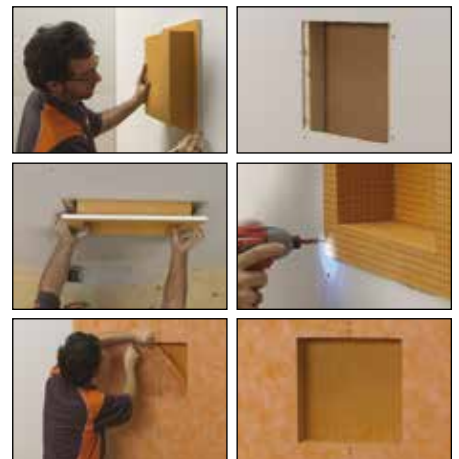
Intégration dans des plaques de plâtre
