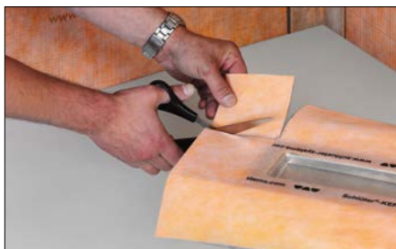
1 KERDI Manschette für den Eckbereich zuschneiden.
