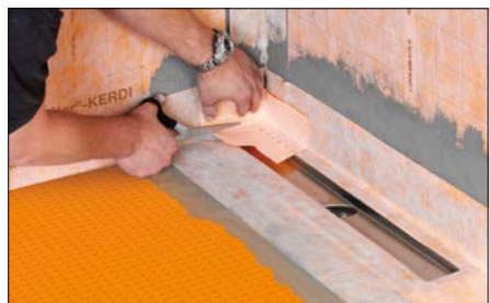
11 KERDI Manschette mit KERDI-COLL-L dicht verkleben. Die im Lieferumfang enthaltene Schlüter-KERDI-KERECK Innenecke zuschneiden ...
