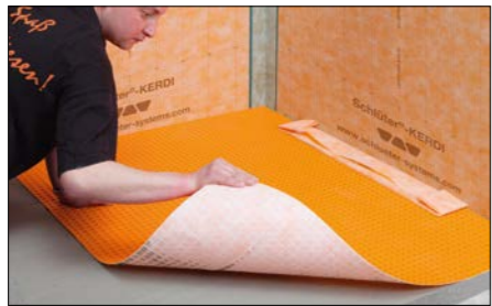
11 DITRA 25 aufkleben – Stöße sind mit KERDI-KEBA unter Verwendung von KERDI-COLL-L abzdichten (siehe Produktdatenblatt 6.1).
