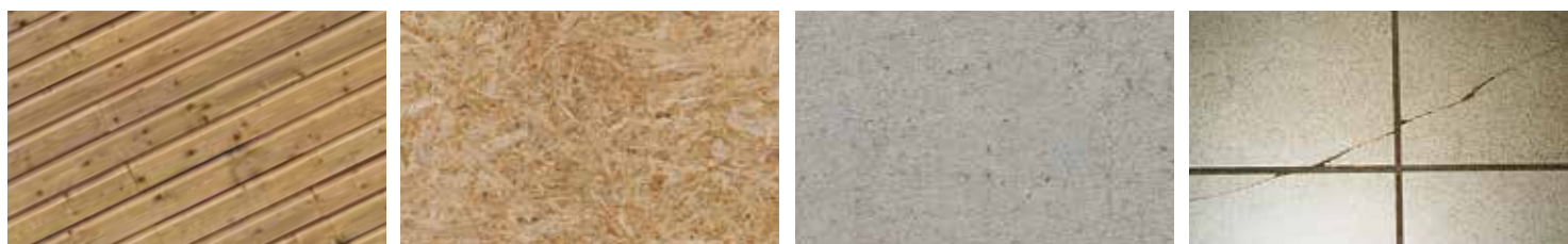
Pose sur : — plancher bois — panneau bois — béton — ancien carrelage fissuré...
