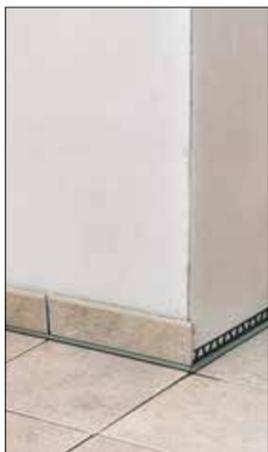
Même si cela n'apparaît pas au premier coup d'œil : les carreaux, les chapes et même le béton sont des matériaux "vivants" quelle que soit leur composition et sont soumis à d'incessantes variations de forme. Le séchage, la charge, les changements de taux d'humidité et de température induisent des variations de forme dont les effets peuvent s'additionner.
