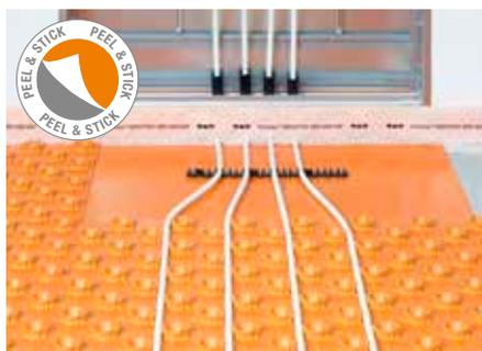
Le panneau lisse Schlüter-BEKOTEC-ENFGK-PS se monte dans la zone du collecteur afin de faciliter le montage des tubes de chauffage dans le coffret pour collecteur. Le panneau est autocollant au verso et muni d'un film protecteur.
