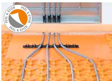
Le panneau lisse Schlüter-BEKOTEC-ENFG-PS se monte dans la zone du collecteur afin de faciliter le montage des tubes de chauffage dans le coffret pour collecteur. Le panneau est autocollant au verso et muni d'un film protecteur.
