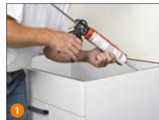
**1** Appliquer la colle de montage Schlüter-KERDI-FIX sur les surfaces d'appui du plan de travail de cuisine.
