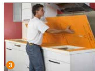
**3** Si la crédence doit elle aussi être carrelée, mettre en place un panneau de 9 ou 12,5 mm sur la surface préalablement enduite de mortier colle.
