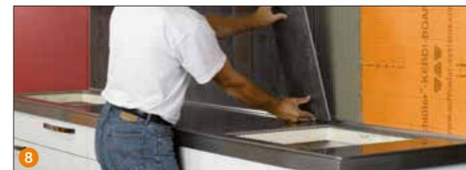
**8** Sur la crédence, appliquer du mortier-colle à l'aide d'une spatule crantée adaptée au revêtement carrelé. Coller les carreaux découpés en veillant à ce qu'ils appliquent sur toute leur surface.
