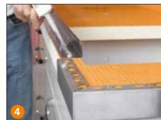
**4** Enduire de Schlüter-KERDI-FIX les profilés d'arête découpés aux dimensions voulues et les appliquer. Il est en outre possible de poser et de coller le profilé Schlüter-RONDEC de forme arrondie, symétrique.
