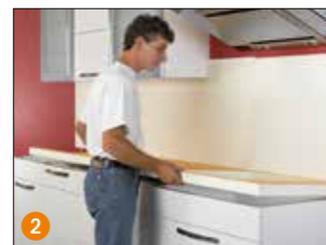
**2** Poser Schlüter-KERDI-BOARD. L'ancien plan de travail déposé (le cas échéant) sert de gabarit, par exemple pour les découpes de l'évier ou de la table de cuisson. Les découpes peuvent s'effectuer à l'aide d'un simple cutter.
