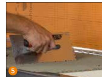
**5** Appliquer du mortier colle sur le panneau Schlüter-KERDI-BOARD à l'aide d'une spatule crantée de taille adaptée au revêtement carrelé.
