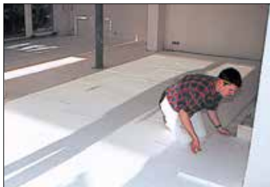
Colocación de aislamientos térmicos y acústicos sobre un soporte resistente y nivelado
