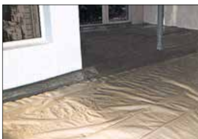
Colocación de la lámina de separación
