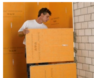
Para realizar tabiques
