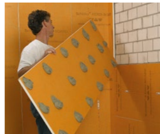
Colocación sobre paredes de obra o soportes mixtos
