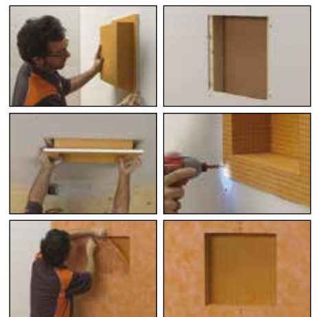
Einbau in Gipskarton
