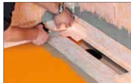
II KERDI Manschette mit KERDI-COLL-L dicht verkleben. Die im Lieferumfang enthaltene Schlüter-KERDI-KERECK Innenecke zuschneiden ...
