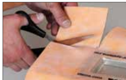
I Schlüter-KERDI Manschette für den Eckbereich zuschneiden.
