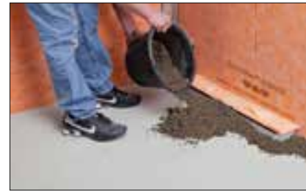
11 Gefälleestrich (2%) der Duschrfläche aufbringen.
