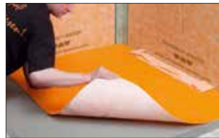
13 Schlüter-DITRA-25 bzw. -DITRA-HEAT aufkleben - Stöße sind mit KERDI-KEBA unter Verwendung von KERDI-COLL-L abzdichten (siehe Produktdatenblatt 6.1 bzw. 6.4).
