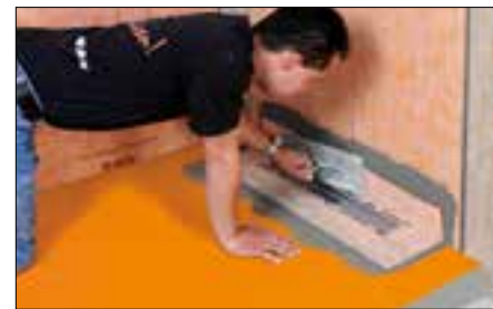
14 Schlüter-KERDI Manschette mit KERDI-COLL-L verkleben. Wand- und Bodenschlüsse sind mit KERDI-KEBA ebenfalls mit KERDI-COLL-L dicht zu verkleben.
