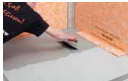
12 Die Erstrichfläche mit Dünnbettmörtel versehen. Die Zahnungsempfehlung bei der Verwendung von Schlüter-DITRA 25 ist 3 x 3 oder 4 x 4 mm. Bei der Verwendung von Schlüter-DITRA-HEAT, 6 x 6 mm.
