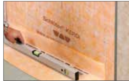
10 Rinnenkörper mit Wasserwaage ausrichten.
