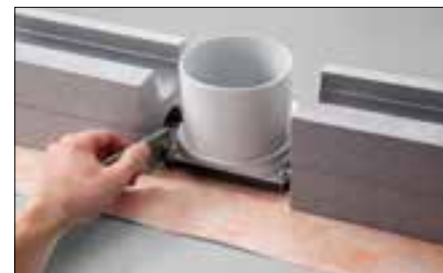
4 Zum Erreichen der minimalen Aufbauhöhe von 120 mm ist der Adapter zu kürzen. Hierzu Adapter mittels des beigefügten Imbusschlüssels vom Rinnenkörper lösen, abnehmen ...
