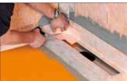
11 KERDI Manschette mit KERDI-COLL-L dicht verkleben. Die im Lieferumfang enthaltene Schlüter-KERDI-KERECK Innenecke zuschneiden ...
