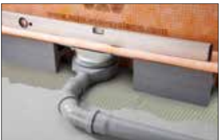
10 Rinnenkörper mit Wasserwaage ausrichten und Dichtheitsprüfung vornehmen.
