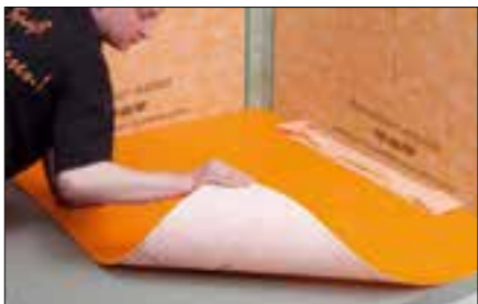
13 DITRA-25 bzw. DITRA-HEAT aufkleben - Stöße sind mit KERDI-KEBA unter Verwendung von KERDI-COLL-L abzudichten (siehe Produktdatenblatt 6.1 bzw. 6.4).
