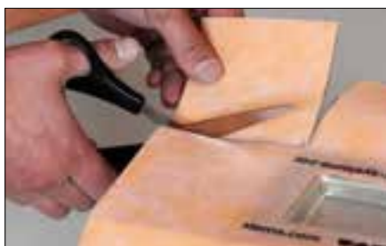
1 KERDI Manschette für den Eckbereich zuschneiden.
