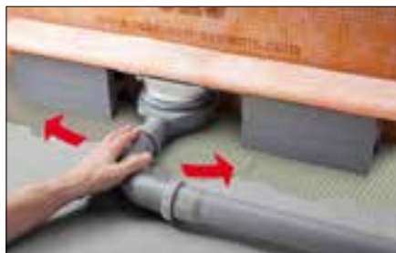
9 Ablaufrohr (bauseits) anbringen und ausrichten.
