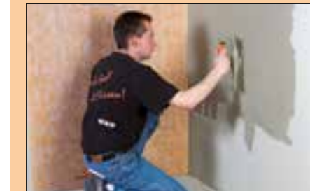
1 Dünnbettmörtel (Zahnung 3 x 3 mm) zur Verklebung der Verbundabdichtung Schlüter-KERDI aufbringen.
