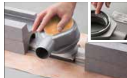
7 Ablaufgehäuse auf den Adapter setzen und eindrücken (mitgeliefertes Gleitfett verwenden).
