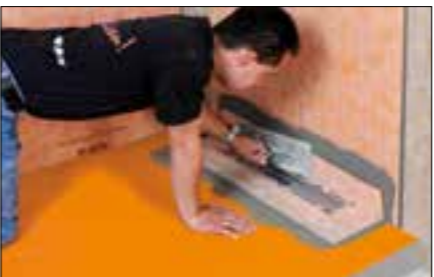
14 KERDI-Manschette mit KERDI-COLL-L verkleben. Wand- und Bodenanschlüsse sind mit KERDI-KEBA ebenfalls mit KERDI-COLL-L dicht zu verkleben.
