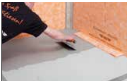
12 Die Estrichfläche mit Dünnbettmörtel versehen. Die Zahnungsempfehlung bei der Verwendung von Schlüter-DITRA 25 ist 3 x 3 oder 4 x 4 mm. Bei der Verwendung von Schlüter-DITRA-HEAT, 6 x 6 mm.
