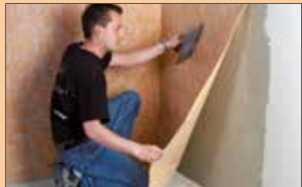
2 Schlüter-KERDI Bahn aufbringen und glätten.
