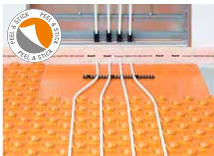
Die Ausgleichsplatte Schlüter-BEKOTEC-ENFGK-PS wird vor Heizkreisverteilern eingesetzt, um die Montage der Heizrohre im Verteilerschrank zu erleichtern. Die Platte ist rückseitig selbstklebend und mit Schutzfolie versehen.
