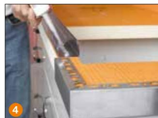
**4** Die zugeschnittenen Kantenprofile werden mit Schlüter®-KERDI-FIX versehen und auf-gesetzt. Zusätzlich kann das syme-trisch gerundete Profil Schlüter®-RONDEC mit aufgesetzt und ver-klebt werden.
