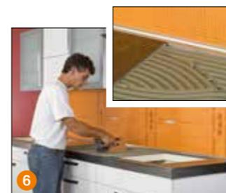
**6** Die „trocken“ aufgesetzten Hohlkehprofile werden hierbei im Fliesenkleber eingebunden.
