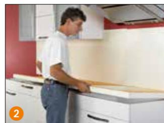
**2** Schlüter®-KERDI-BOARD aufsetzen. Die zuvor ausgebaute Arbeitsplatte (wenn vorhanden) dient hierbei als Schablone für Spülen- bzw. Herdplattenausschnitte. Diese können einfach mit einem Cuttermesser herausgetrennt werden.
