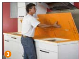
**3** Für eine evtl. Wandbefliesung wird eine Verlegeplatte, 9 oder 12,5 mm auf Fliesenkleber ange-setzt.
