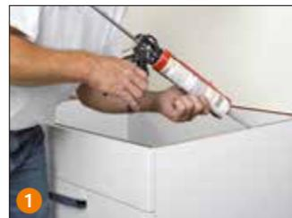
**1** Die Auflageflächen für die Küchenarbeitsplatte werden mit dem Montagekleber Schlüter®-KERDI-FIX versehen.
