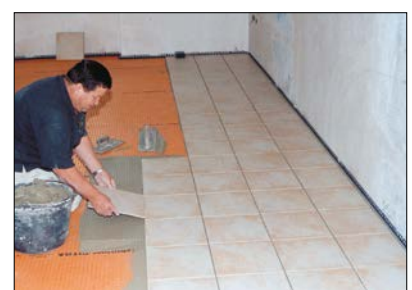
12 Verlegung des Fliesenbelags auf DITRA in Dünnbettmörtel.
