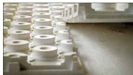
Udlægning og samling af den noprede Schlüter-BEKOTEC-EN/P (-EN/PF) plade til afretningslag
