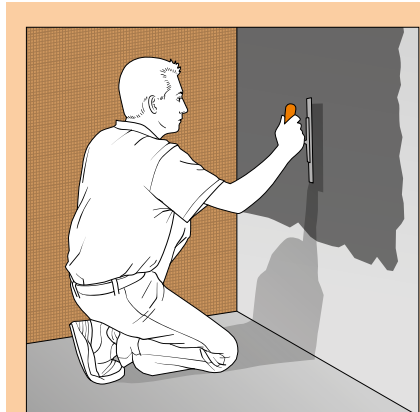
1 Dünnbettmörtel (Zahnung 3 x 3 mm) zur Verklebung der Verbundabdichtung Schlüter-KERDI aufbringen.
