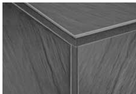
Vytvoření rohu šikmým řezem
