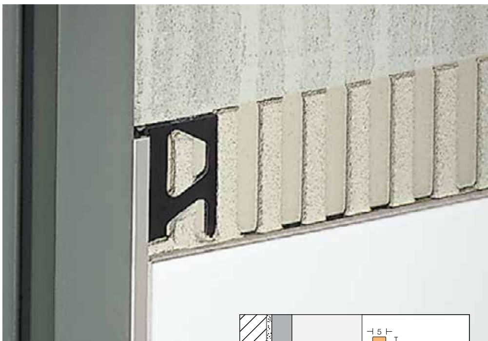
Schlüter-DILEX-BWA é instalado no revestimento de cerâmica, como junta de ligação contra elementos fixos. Áreas de aplicação são, por exemplo, ligações de parede contra caixilhos de janelas ou portas, bem como de pavimentos contra revestimentos de parede e rodapés, elementos de portas, armários encastrados, etc.
