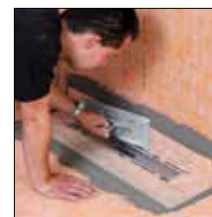
Sobre ponto 4. Colar a guarnição KERDI com KERDI-COLL-L
