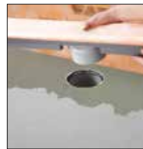
Sobre ponto 4. Colocar o corpo do canal com o suporte do canal
