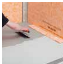
Sobre ponto 7. Aplicar argamassa de camada fina
