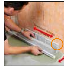
Sobre ponto 1. Alinhar o suporte do canal
