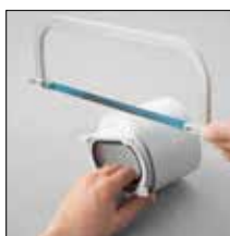
Sobre ponto 1. Encurtar o adaptador
