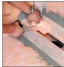
Sobre ponto 2. Colar a guarnição KERDI/cortar o ângulo interno KERECK
