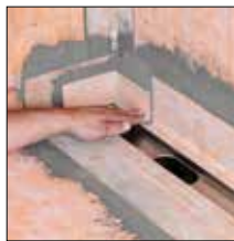
Sobre ponto 3. Colar o ângulo interno KERECK
