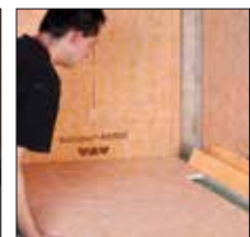
Sobre ponto 3. Empurrar a placa com inclinação por baixo do rebordo do corpo do canal
