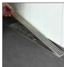
Sobre ponto 4. Colocar a cobertura
