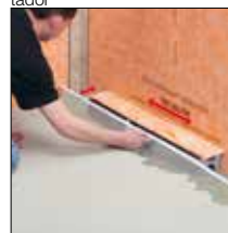
Sobre ponto 4. Alinhar o suporte do canal
