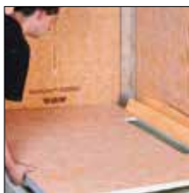
Sobre ponto 3. Empurrar a placa com inclinação por baixo do rebordo do corpo do canal
