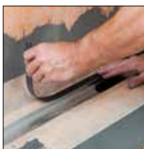
Sobre ponto 1. Em caso de instalação na parede: colar as faixas de cobertura na parede
