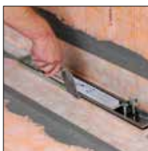
Sobre ponto 3. Suportar a moldura/ colocar mosaicos em toda a superfície
