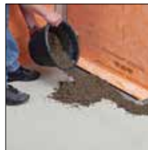
Sobre ponto 5. Aplicar a betonilha
