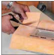
Sobre ponto 1. Cortar a guarnição KERDI
