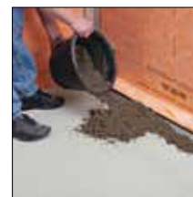
Sobre ponto 3. Aplicar a betonilha de nivelamento
