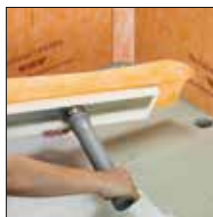
Sobre ponto 2. Instalar o tubo de escoamento
