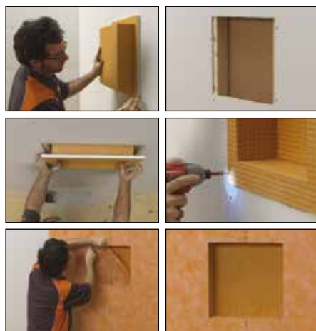
Instalação em gesso cartonado
