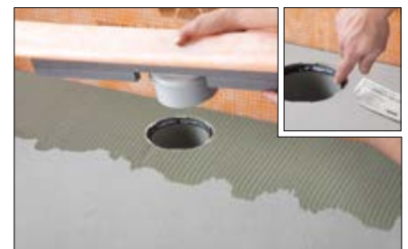
9. Ebenen Flächenuntergrund im Bereich des Rinnenträgers mit Dünnbettmörtel versehen. Rinnenkörper inkl. Rinnenträger auf das Ablaufgehäuse aufsetzen und eindrücken (mitgeliefertes Gleiffett verwenden) Ggf. notwendiger Höhenausgleich kann durch Mörtelbatzen erfolgen. Beim Wandeinbau ist der Rinnenkörper in Abhängigkeit von Wandabstand und der Wandbelagsdicke auszurichten (Details siehe Rückseite).
