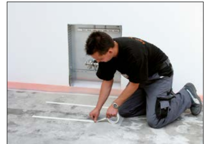
3 Verteilerbereich – beiliegendes Doppelklebeband auf dem Boden anbringen.
