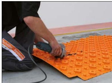
8 a Verarbeiten der Estrichnoppenplatte – Schneiden im Noppenbereich: Winkelschleifer benutzen.
