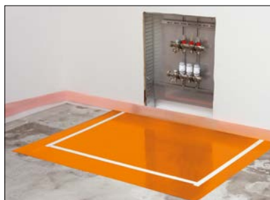
5 Verteilerbereich – beigefügte Doppelklebebänder aufbringen.
