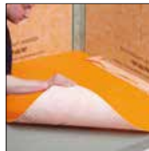
bij 7. Verlijm Schlüter®-DITRA resp. DITRA-HEAT erop vast
