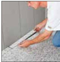
bij 6. Verlijm de bekleding – laat bij het voegen de gleuf aan de tegeldrager vrij
