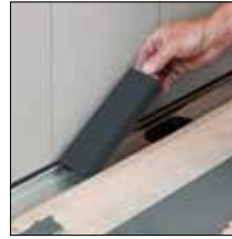
bij 2. Plaats de afstandhouders in de goot
