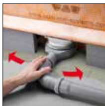
bij 5. Lijn het afvoerbuis uit
