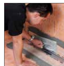
bij 4. KERDI-manchet met KERDI-COLL-L verlijmen
