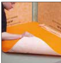
bij 8. Verlijm Schlüter®-DITRA resp. DITRA-HEAT erop vast
