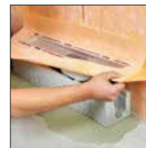
bij 2. Goot plaatsen
