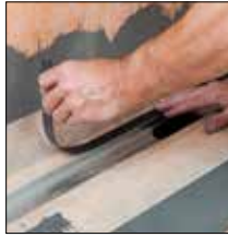
bij 1. Bij wandinbouw: lijm de oplegstrook tegen de wand aan vast
