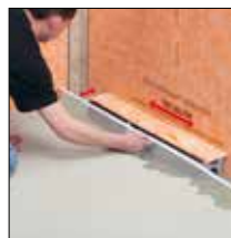
bij 4. Lijn de gootdrager uit
