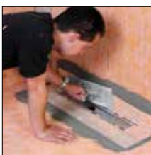
bij 4. KERDI-manchet met KERDI-COLL-L verlijmen
