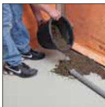
bij 6. Breng een dekvloer met afschot aan
