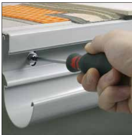
Montage achteraf van het gootsysteem Schlüter®-BARIN aan randprofielen zonder opnamegroef
