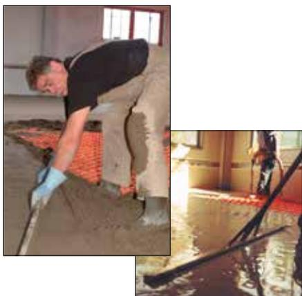
Avant de couler la chape, il convient de contrôler l'étanchéité du système de chauffage en procédant à un essai de pression de 6 bars. S'assurer que le chauffage ne risque pas d'être déclenché pendant la coulée et le processus de prise de la chape.
