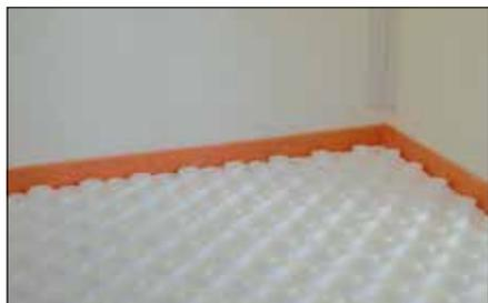
Mise en place de la bande périphérique avec embase à coller. Le choix du type de bande se fait en fonction du type de chape (voir tableau ci-dessous).
