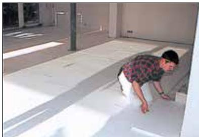
Pose de l'isolation thermique et/ou phonique sur un support parfaitement plan, porteur et techniquement recevable.
