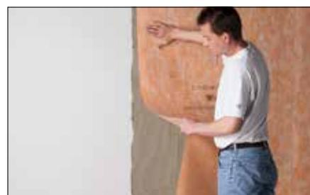
Schlüter-KERDI est une natte d'étanchéité en polyéthylène dont les deux faces sont revêtues d'un non-tissé permettant un ancrage efficace dans le mortier-colle.
