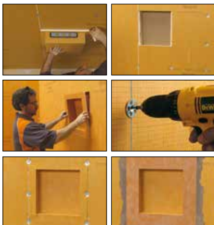
Mise en œuvre dans KERDI-BOARD
