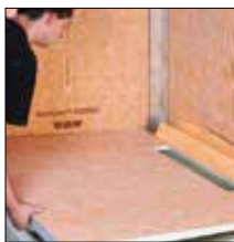
=> 3. Mettre en place le panneau avec pente de sorte qu'il arrive à fleur avec le support de caniveau
