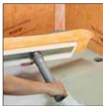
=> 2. Mettre en place le tuyau d'évacuation
