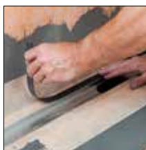
=> 1. Mise en œuvre le long d'un mur : coller la bande de recouvrement
