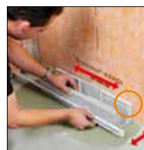
=> 1. Ajuster le support de caniveau
