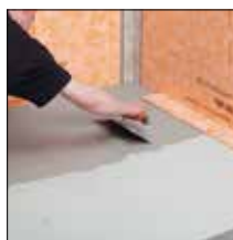
=> 6. Déposer du mortier-colle
