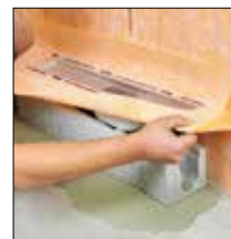
cf. point 2. Mettre en place le corps de caniveau
