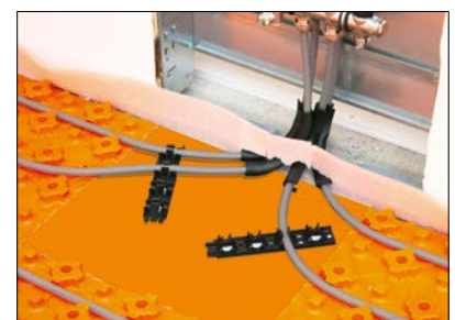
11 Verteilerbereich – Rohrklemmleisten Schlüter-BEKOTEC-BTZRKL zur Rohrführung nach Bedarf aufkleben.
