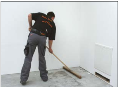
1 Reinigen des ausreichend tragfähigen und ebenflächigen Untergrundes.
