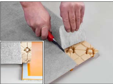
9 Türbereich/Verteilerbereich – zur Vermeidung eines Höhenversatzes ist im Übergangsbereich die 5 mm Trittschalldämmung der Noppenplatte EN 18 FTS passgenau zu entfernen.
