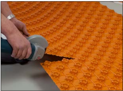
7 Verarbeiten der Estrichnoppenplatte – Zuschneiden mit dem Winkelschleifer. In dem Zuge die Noppen der BEKOTECEN 18 FTS Startplatten (siehe Punkt 4) im Randbereich zur Vermeidung von Schallbrücken entfernen.
