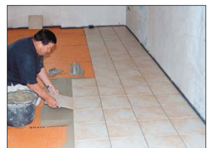
12 Verlegung des Fliesenbelags auf DITRA in Dünnbettmörtel.
