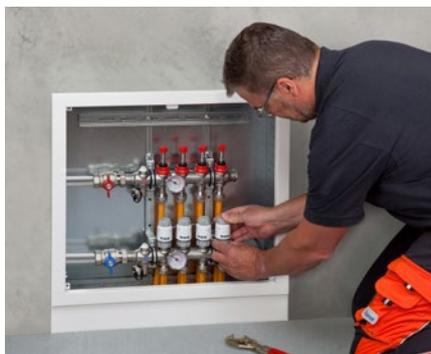
Des solutions complètes : le système de plancher chauffant-rafraîchissant Schlüter-BEKOTEC-THERM comprend une technique moderne de régulation, avec différents collecteurs, électrovannes et thermostats, permettant la réalisation d'un système de chauffage efficace.
