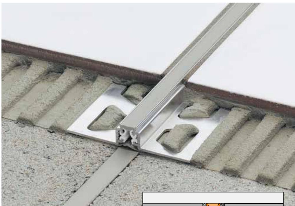
Les profilés-supports en aluminium sont sensibles aux alcalins. En présence d'humidité, les matériaux à base de ciment présentent une alcalinité qui peut, selon la concentration et la durée de contact, corroder l'aluminium (formation d'hydroxyde d'aluminium). Le profilé doit être complètement noyé dans la couche de contact avec le carreau.
