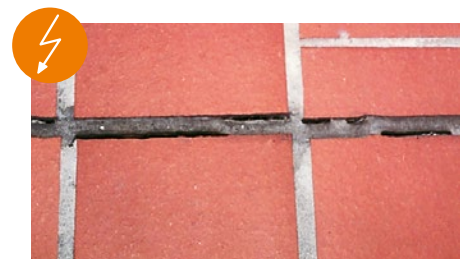
Patologías que se evitan con el uso de los perfiles de juntas de movimiento Schlüter®-DILEX
