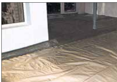
Einbau der Trennlage
