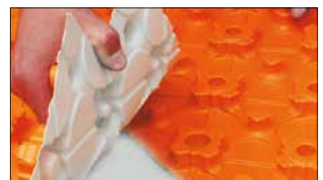
Auslegen und Zusammenfügen der Estrich-Noppenplatte Schlüter-BEKOTEC-EN 23 F
