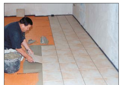
12 Verlegung des Fliesenbelags auf DITRA in Dünnbettmörtel.
