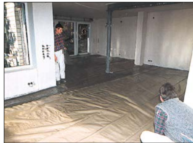
2 Einbau einer Abdecklage bei Verwendung von Fließestrichen.
