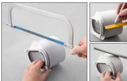
7. ... und bis zur Mindesteinstektiefe von 30 mm kürzen (max. Einstektiefe 90 mm). Anschließend Schnittkante anphasen.
