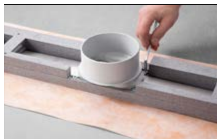
8. Adapter wieder auf Rinnenkörper stecken und fest verschrauben.
